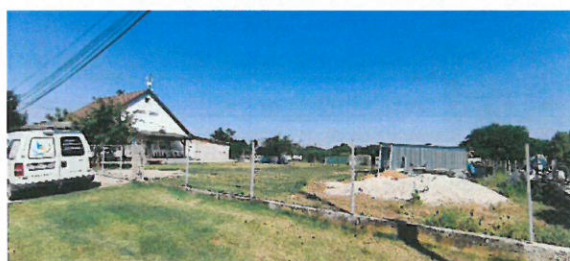
282 hrsz-ú telek és a 284 hrsz-ú ingatlan a Bartók Béla utca irányából
