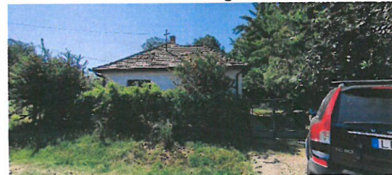
249 hrsz-ú telken álló ház
